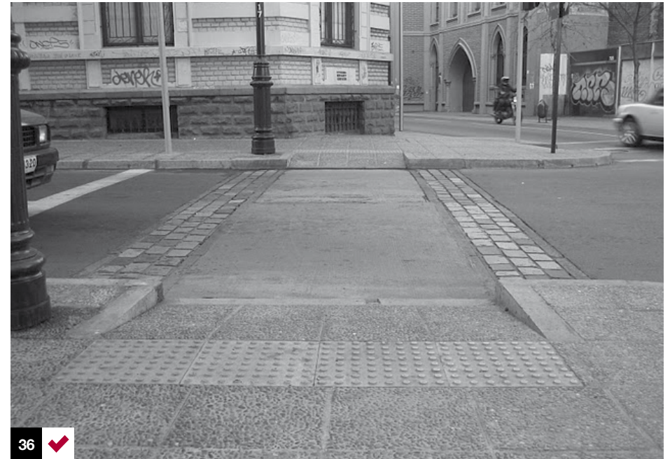
Foto 36: rebaje con buen uso de texturas y diferenciación de pavimentos. Santiago, Chile.
