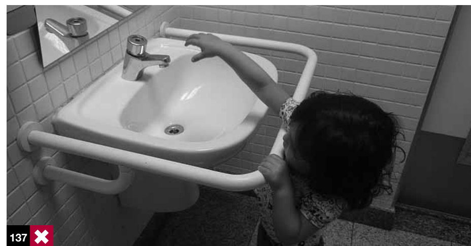
Foto 137: barra que no permite la aproximación a la grifería. Los elementos de apoyo no deben colocarse frente a un lavamanos.
