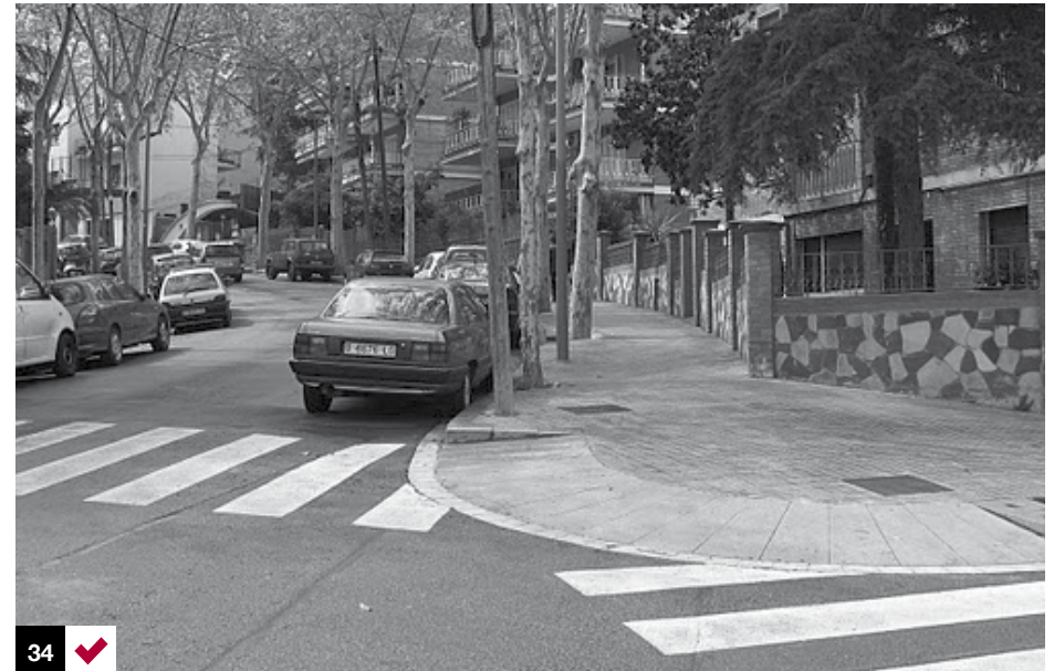
Foto 34: rebaje en esquina de pendiente adecuada. Se produce un descenso completo de ésta, coincidiendo con el paso cebrado de circulación peatonal. La textura del rebaje advierte del cruce. Barcelona, España.
