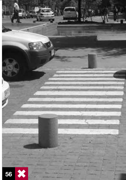
Foto 56: los pilotes interfieren con el cruce peatonal. No deben ubicarse en los centros de éstos. Santiago, Chile.
