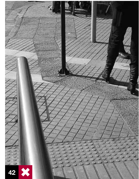
Foto 42: mal uso y exceso de texturas. Señalización vertical en medio de lo que se pretende sea la franja de circulación segura. Paradero Transantiago. Santiago, Chile.
