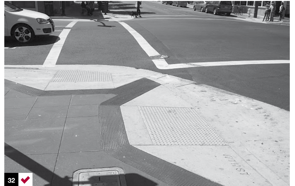
Foto 32: rebaje en esquina con una pendiente adecuada. Las alas laterales también se desarrollan con buena pendiente para no interferir con la circulación peatonal. La textura de advertencia indica la proximidad del cruce delimitado en la calzada. San Francisco, EE.UU.
