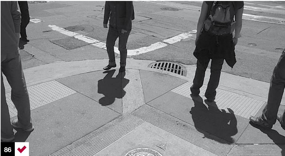
Foto 86: la esquina baja completa en el área demarcada en la calzada para el cruce. San Francisco, EE.UU.
