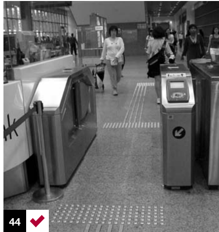
Foto 44: uso de pavimento táctil en estación de metro. Tokio, Japón.
