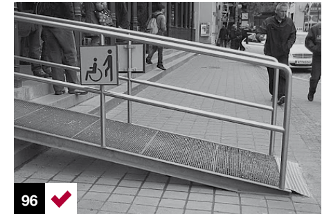
Foto 96: rampa provisoria a antigua estación de trenes indicando la necesidad de asistencia por su pendiente. Augsburg, Alemania.
