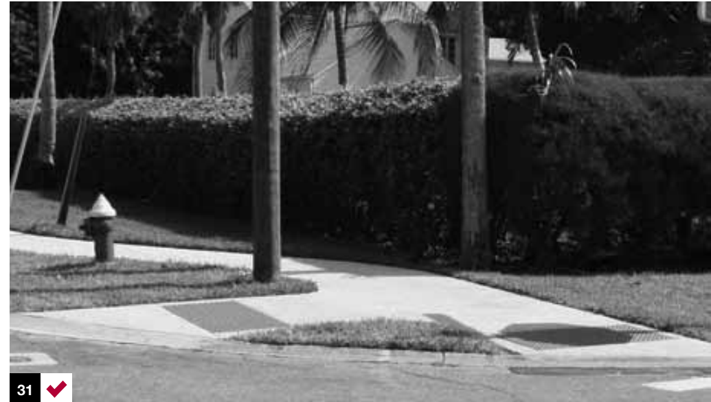
Foto 31: vereda angosta que baja en todo su ancho al nivel de la calzada. Naples, EE.UU.
