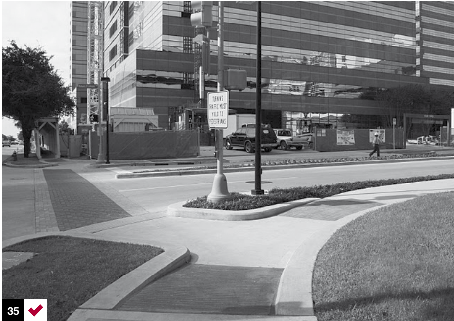
Foto 35: rebaje de vereda angosta, la vereda baja en todo su ancho con una pendiente adecuada y cambio de textura para indicar la cercanía del cruce peatonal. Houston, EE.UU.
