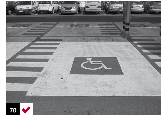
Foto 70: estacionamiento de buenas dimensiones y señalización. Ubicarlos todos juntos favorece el uso correcto de éstos. Santiago, Chile.
