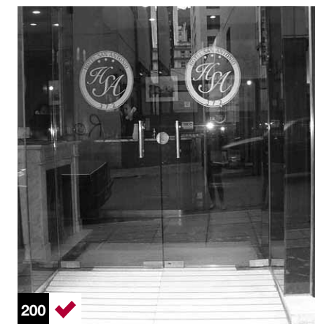
Foto 200: eliminando un peldaño se adaptó el acceso al hotel. Buenos Aires, Argentina.
