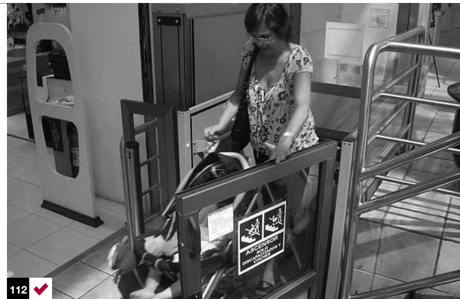
Foto 112: plataforma elevadora para adaptar una circulación con cambio de nivel. No se debieran contemplar en un proyecto nuevo. Santiago, Chile.
