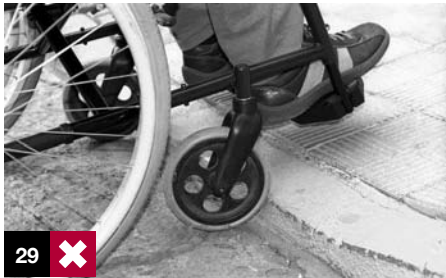
Foto 29: rebaje no practicable, mal diseño por diferencias de nivel entre vereda y calzada.
