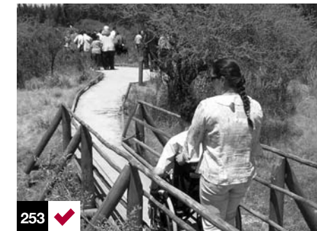
Foto 253: pasarela Sendero Las Orquídeas – Conaf. Lago Peñuelas, Chile.
