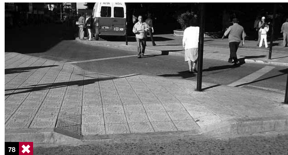
Foto 78: los pasos intermedios deben ser a nivel con la calzada y mantener el mismo ancho que la demarcación del cruce. El que se muestra en la foto exige un exceso de esfuerzo a una persona en silla de ruedas para lograr el cruce. Temuco, Chile.
