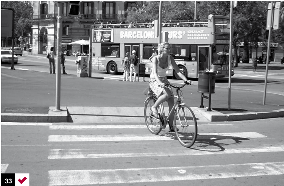
Foto 33: rebaje de vereda en todo el ancho del cruce peatonal, de buena pendiente y protecciones laterales. Barcelona, España.
