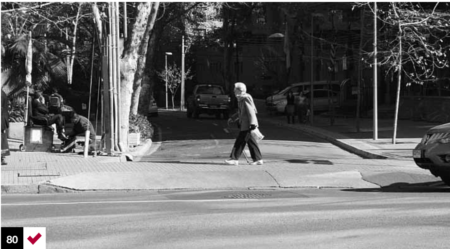
Foto 80: si se desea privilegiar la circulación peatonal, la vereda mantiene su altura en el cruce de la calzada. Santiago, Chile.
