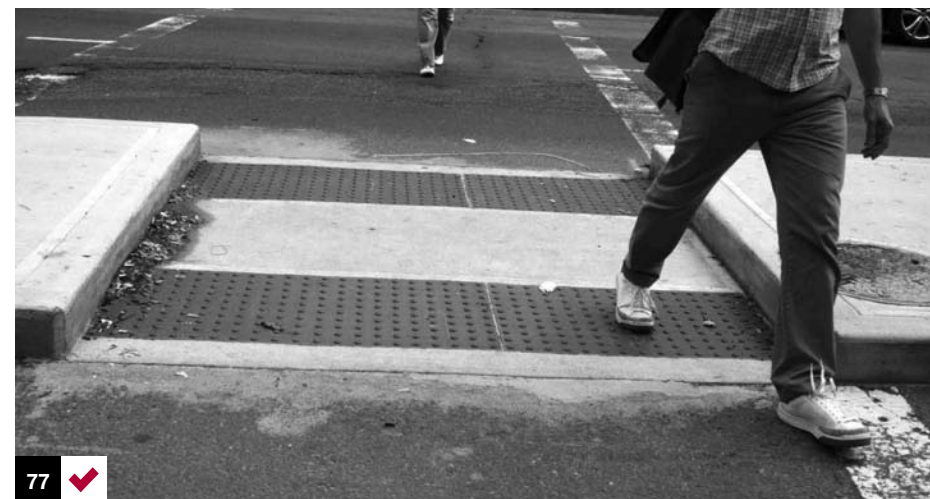
Foto 77: cruces intermedios de diseño universal. Una franja de guía táctil de alerta advierte del cruce, se rebaja en todo su ancho y mantiene la cota de la calzada. Nueva York, EE.UU.
