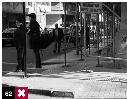
Foto 62: la protección instalada para los peatones bloquea los rebajes de los cruces interrumpiendo la circulación. Santiago, Chile.
