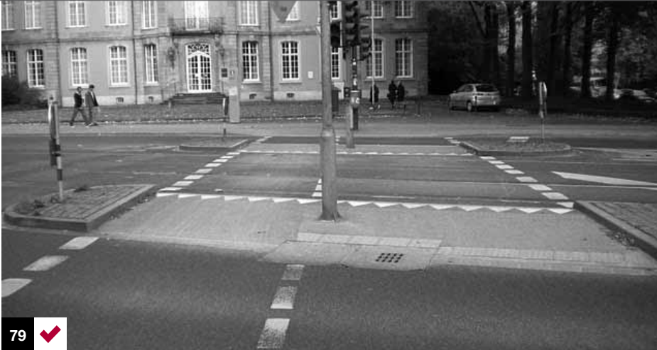
Foto 79: cruces intermedios de diseño universal. Mantienen la cota de la calzada y el ancho completo ofrece oportunidad de cruce a todas las personas. Düsseldorf, Alemania.
